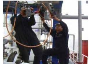
Thi công hệ thống Instrument cho FSO5 Deluge
